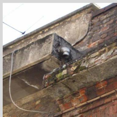
Elementi dell'attuale degrado delle murature perimetrali connessi all'umidità e ai percolamenti.
