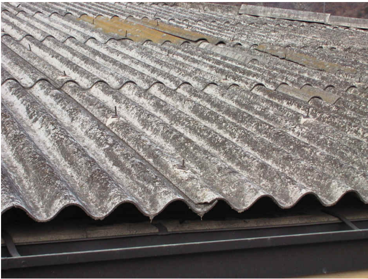
Foto 3 – Lastre ondulate di cemento-amianto; materiale compatto.
