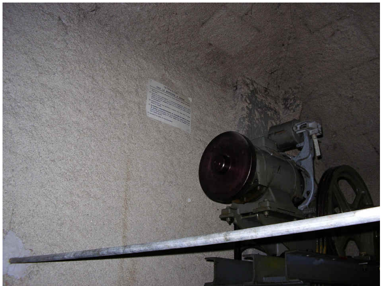
Foto 7 – Rivestimento delle pareti e del soffitto del locale macchinario ascensore (vermiculite espansa e crisotilo); materiale friabile.
