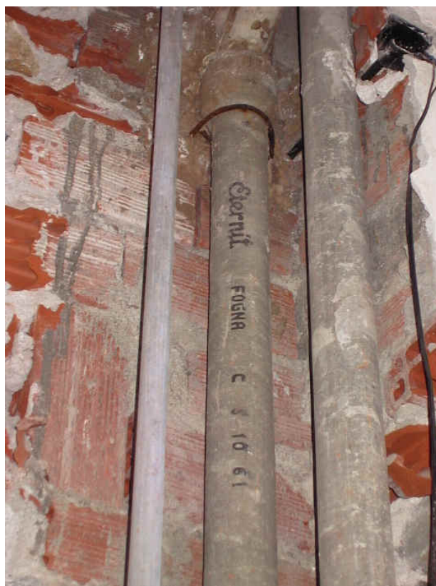
Foto 2 – Tubazione di scarico in Eternit; materiale compatto.
