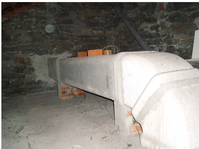
Foto 8 – Tubazione impianto di aerazione in cemento-amianto; materiale compatto.
