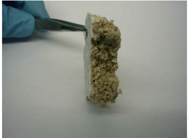
Foto 4 – Intonaco costituito da amianto e vermiculite, materiale friabile.
